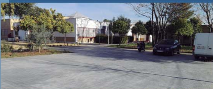
Nuevo acceso a zona de guardia del centro.
