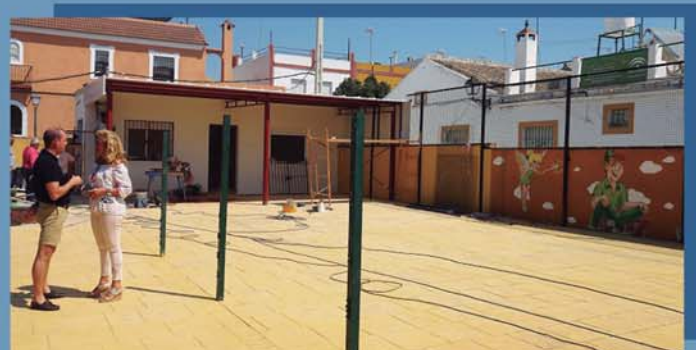
Construcción de una nueva sala multiusos.
