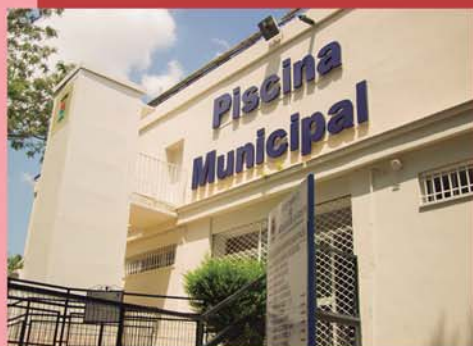
Vista lateral del nuevo ascensor.
