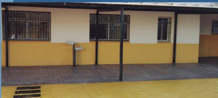
Pavimento de hormigón impreso y fuente bebedero.
