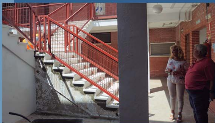
Reparación de una de las escaleras del centro, en agosto de 2018.
