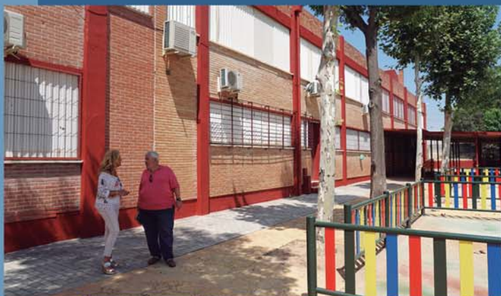
La alcaldesa visita las obras realizadas por el Ayuntamiento, en agosto de 2018.
