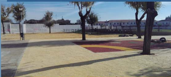
Pavimento de hormigón impreso y juegos infantiles de caucho.
