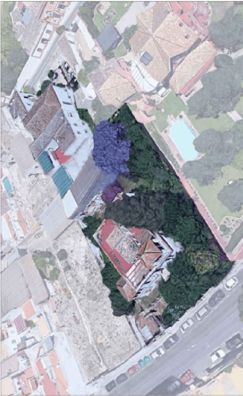
VISTA ACTUAL DESDE CALLE REAL
